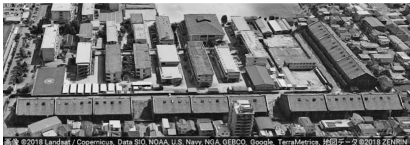
旧広島陸軍被服支廠（広島県 HP より）
