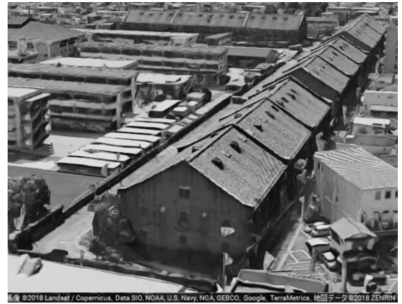
旧広島陸軍被服支廠（広島県 HP より）
